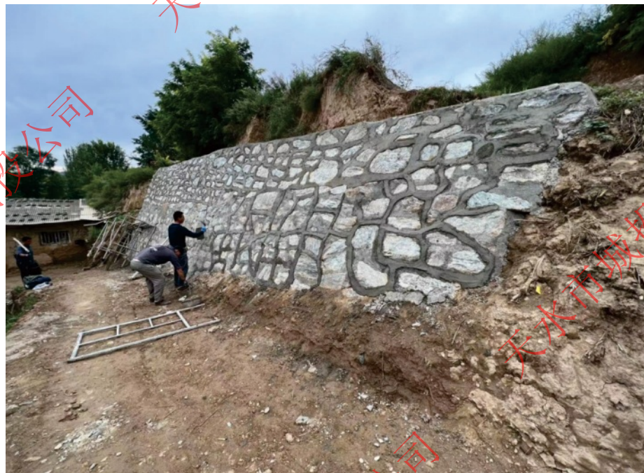
(刘山村小学北路护坡工程)
