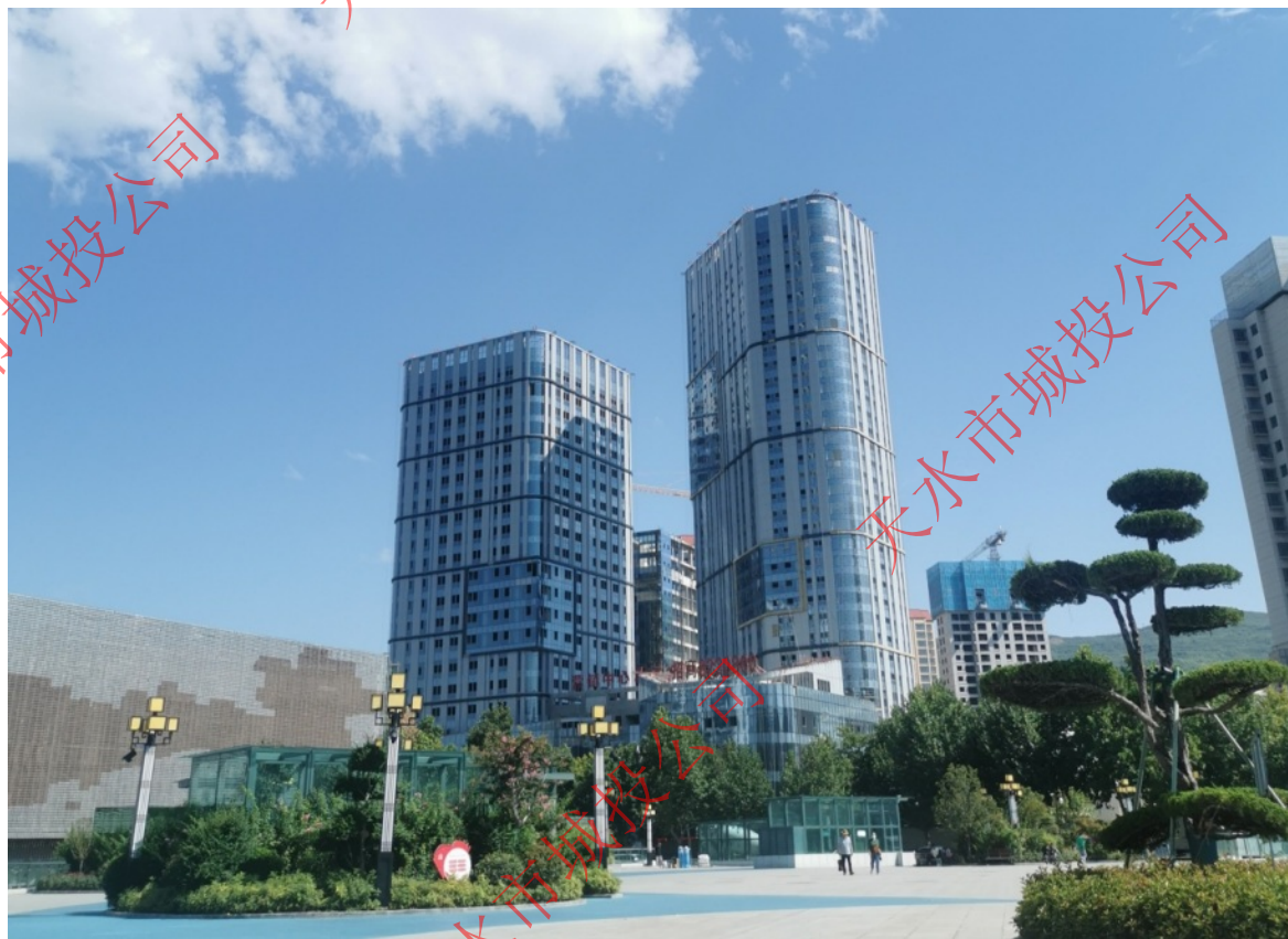
羲元·水岸天街/七里墩综合开发项目二期工程（在建）
